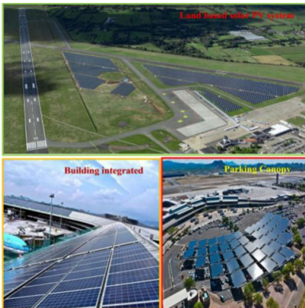
Rys. 16 Trzy sposoby montażu paneli fotowoltaicznych 64
