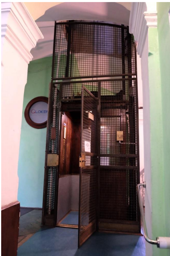
Ryc. 18. Kraków, czynny dźwig osobowy z 1934 r., nr katalogowy urządzenia D01. Fot. Autorki.
