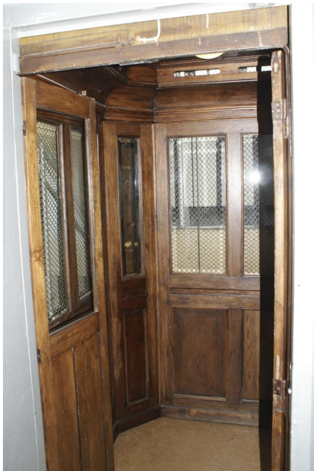
Ryc. 23. Poznań, kabina kątowa czynnego dźwigu osobowego z 1910 r., z widoczną wciągarką bębnową, numer katalogowy urządzenia D54. Fot. Autorki.
