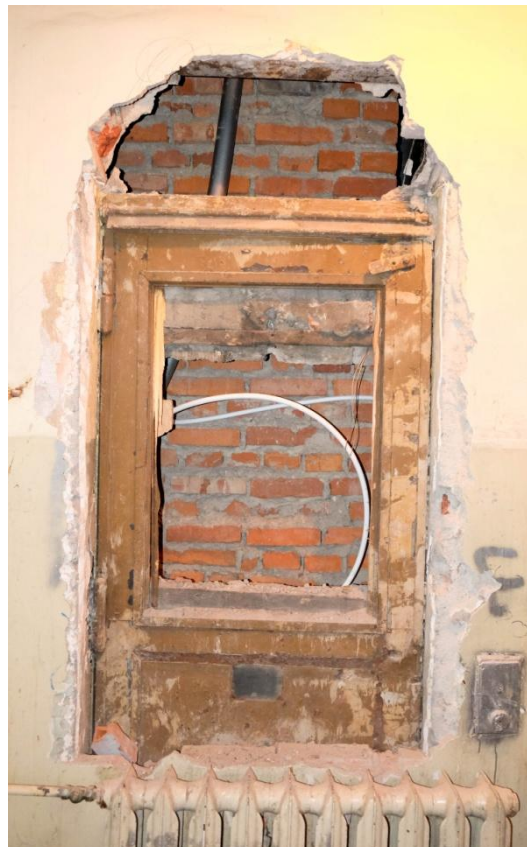
Ryc. 21. Poznań, odsłonięte drzwi sztywne dźwigu osobowego w kamienicy z 1902 r., nr katalogowy urządzenia D48. Fot. Autorki.
