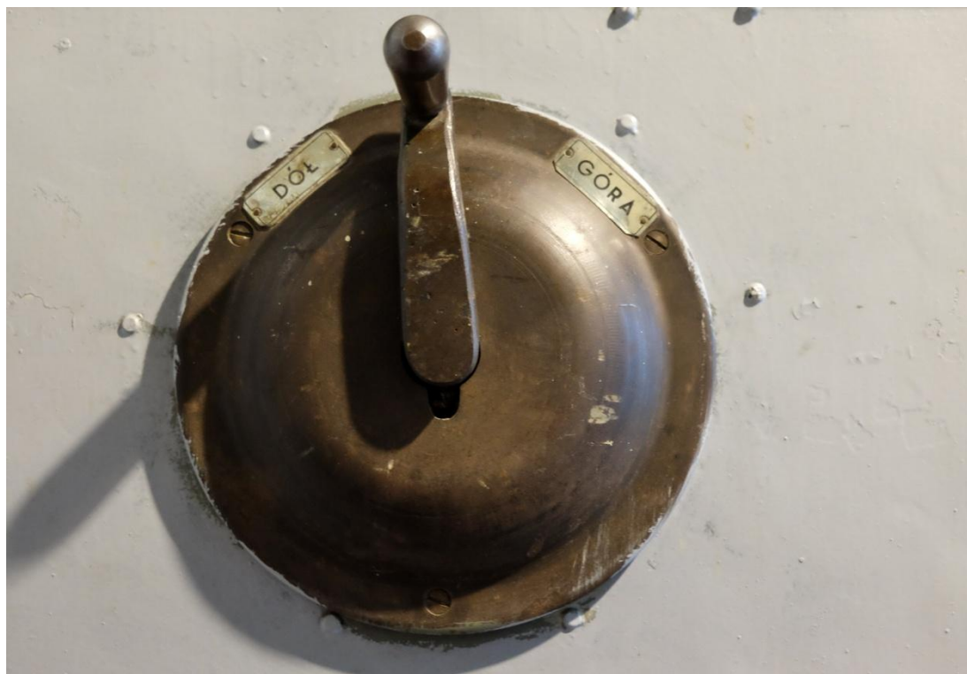
Ryc. 7. Czynna korba sterowa zachowana w dźwigu osobowo-towarowym w Poznaniu, numer katalogowy urządzenia D49. Fot. Autorki.
