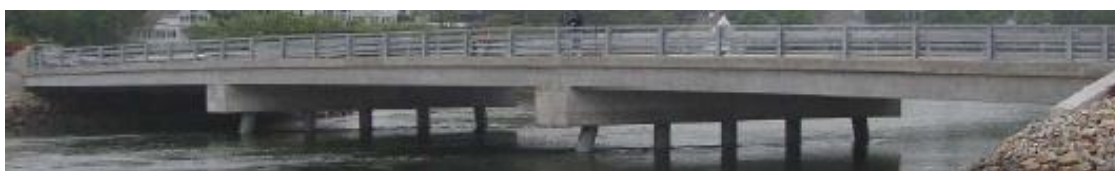
Rys. 2.5 Most Zintegrowany z podporami skrajnymi osadzonymi w nasypie i podatnymi słupami podpór pośrednich (Ogunquit – Maine)
