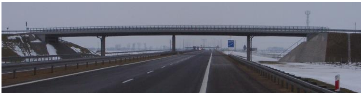
Rys. 5.2 Wiadukt drogowy Pół-zintegrowany WD101 - widok z boku
