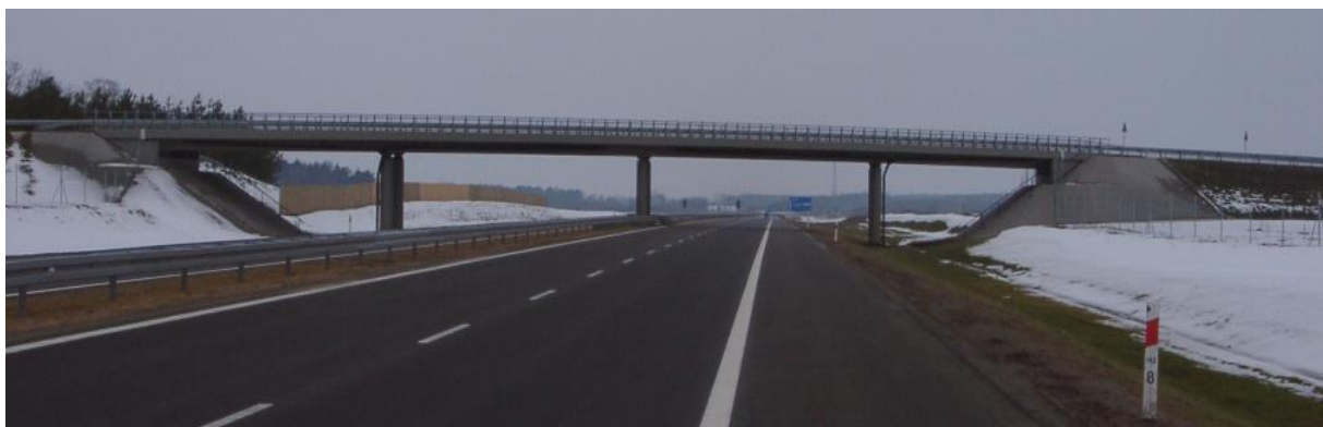
Rys. 2.2 Klasyczny obiekt inżynierski (wiadukt WD94 autostrada A2 – odcinek Komorniki – Nowy Tomyśl)
