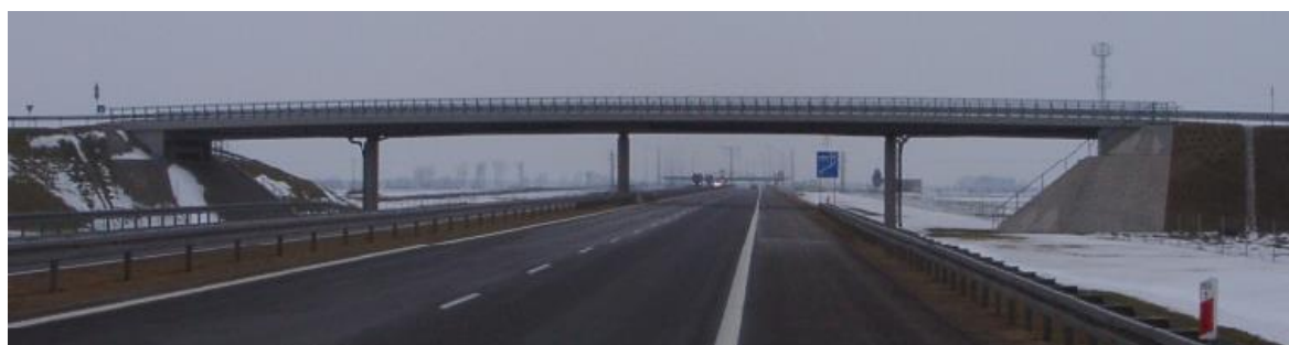
Rys. 14.28 Pół-zintegrowany wiadukt drogowy WD101 na odcinku Komorniki – Nowy Tomyśl autostrady A2 (widok z boku)
