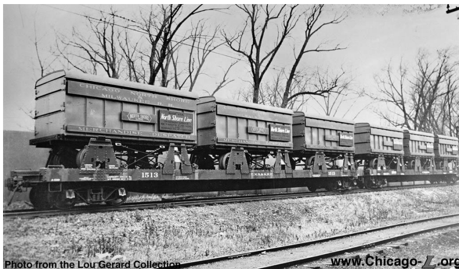
Rys. 2.6. Skład pociągu typu Piggyback należący do Chicago North Shore i Milwaukee Railroad, 1927 r. [76]
