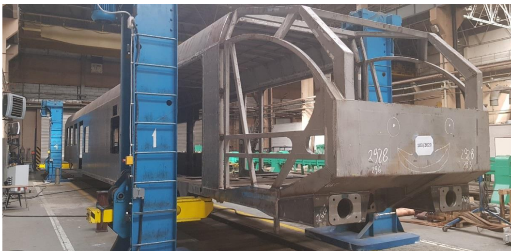
Rys. 6.56. Pudło stalowe członu silnikowego dwunapędowego lekkiego pojazdu szynowego podczas montażu tensometrów
