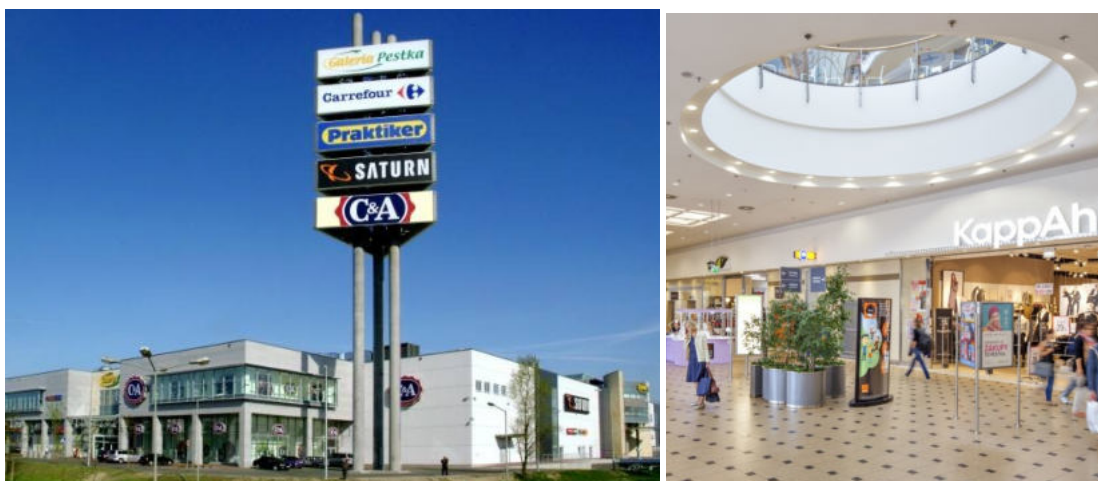
Rys. 4.19. Galeria Pestka – elewacja i wnętrze; fot. Głos Wielkopolski
