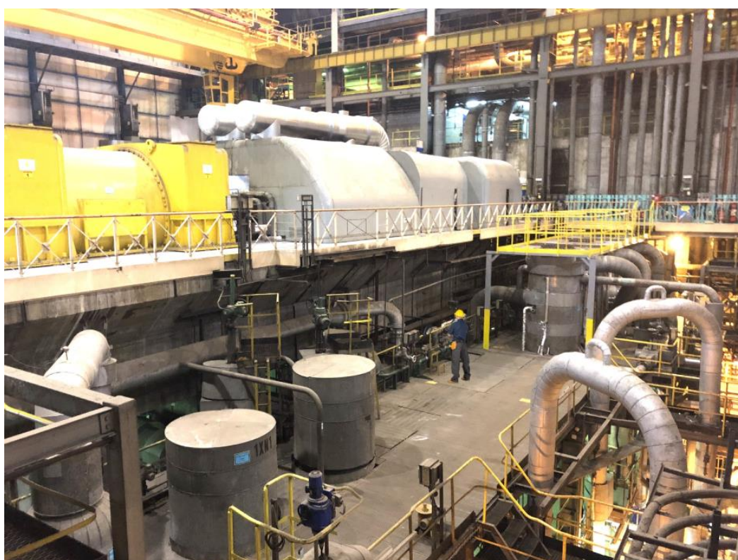
Rysunek 4.2 – Turbozespół 120 MW widok 2
