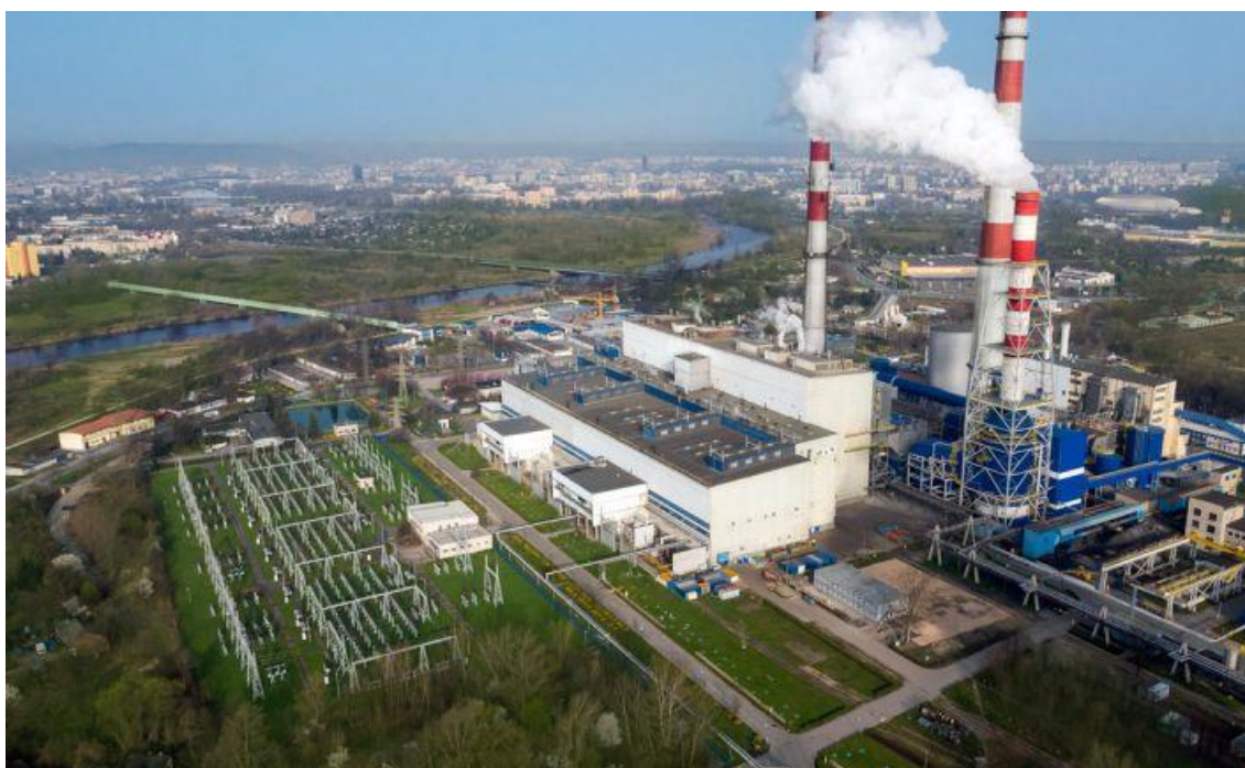
Rysunek 1.2 – Zdjęcie Elektrociepłowni Kraków
